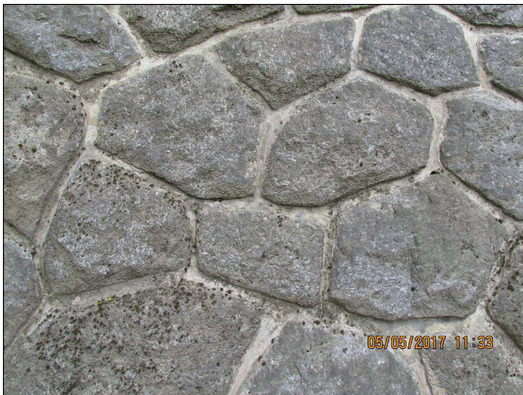
Obr. č. 5 - detail lícového kyklopského zdiva opěrné zdi
