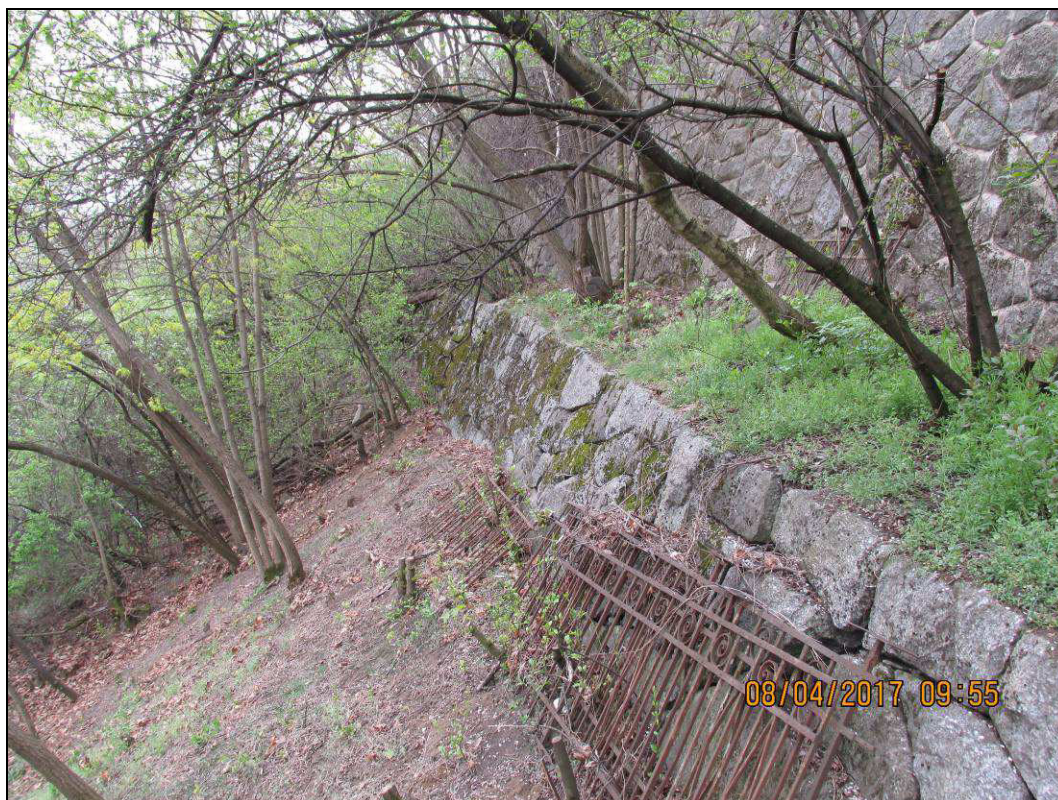
Obr. č. 6 - kamenná rovinanina pod opěrnou zdí
